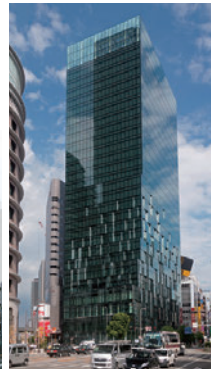
大阪富国生命ビル
